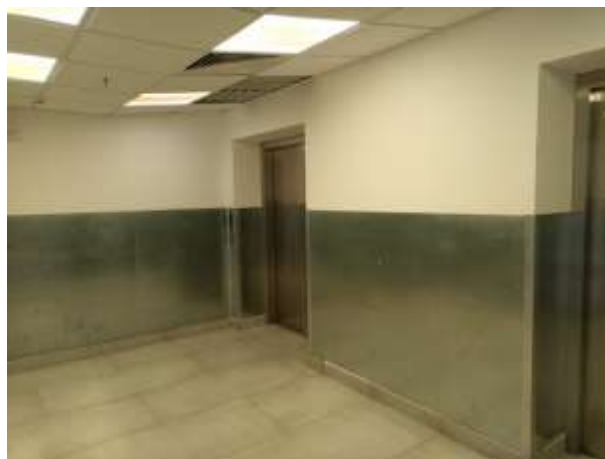
Фото 14. Состояние помещений на -1 этаже
