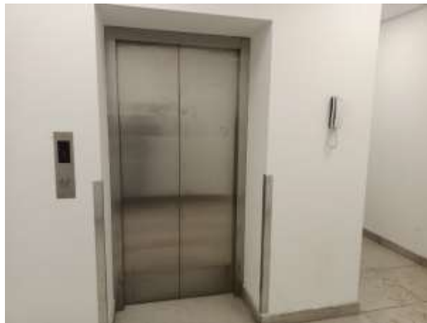
Фото 26. Состояние помещений -2 этаж
