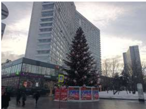
Фото 1. Внешний вид здания
