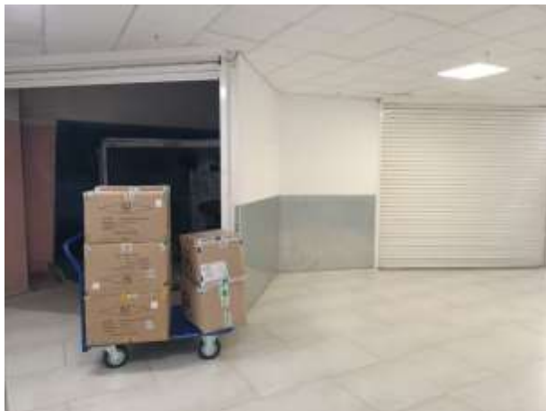
Фото 25. Состояние помещений -2 этаж
