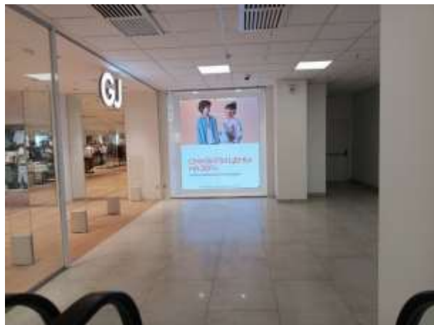
Фото 20. Состояние помещений на 2 этаже
