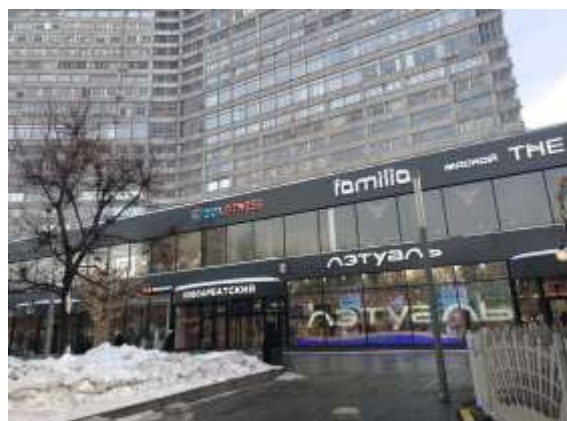
Фото 3. Внешний вид здания
